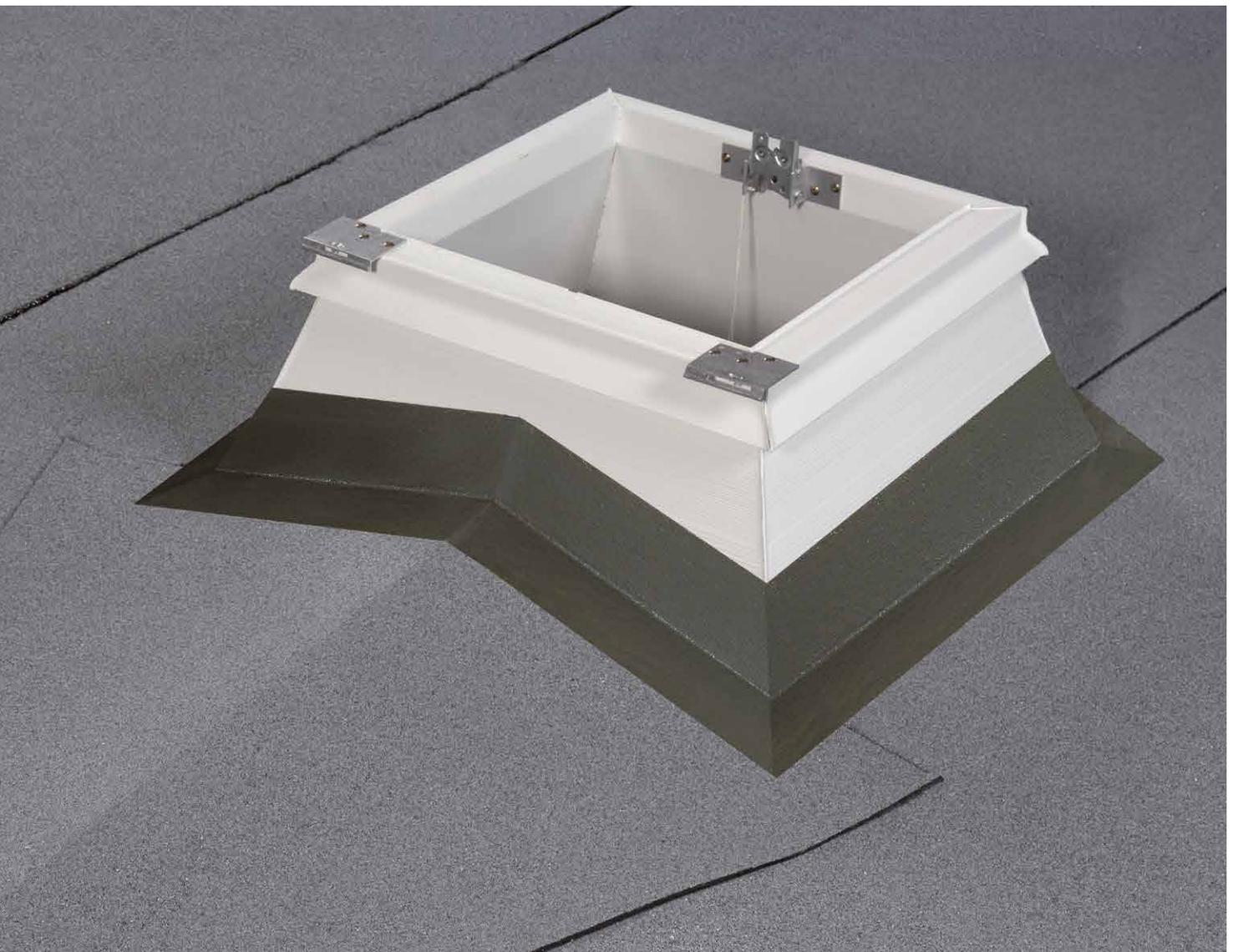
Der Gefällekeil aus Villaperl wurde nach Aushärtung zweilagig mit Icopal-Elastomerbitumenbahnen abgedichtet, der Anschluss wurde mit dem Flüssigkunststoff Profi Dicht hergestellt.
