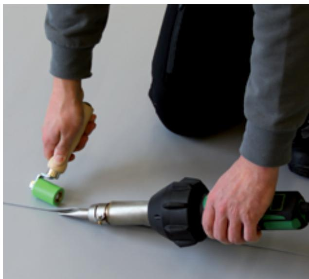
Die Schweißung wird in drei Schritten durchgeführt:
