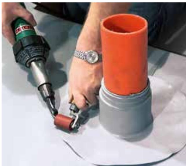
EverGuard TPO è fissata meccanicamente intorno al foro di passaggio della tubazione con almeno tre punti di fissaggio. Il raccordo EverGuard TPO Con Boot è tagliato in modo da poter essere infilato esattamente attorno alla tubazione ed è saldato direttamente alla membrana.
