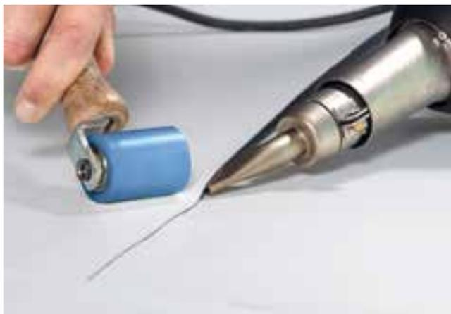
Saldatura manuale con una saldatrice portatile e rullo in silicone.
