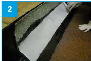
**2)** Applicazione della rete elastica di rinforzo Parathane MAT sul 1° strato resina fresca. Parathane MAT viene puntato e steso in diagonale per velocizzare la posa
